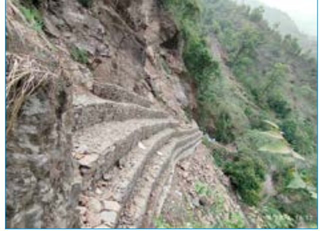
ग्याङ्गसेलिङ्ग गाउँमा रहेको पहिरो नियन्त्रणका लागि निर्माण गरिएको ग्याविन बाल ।
